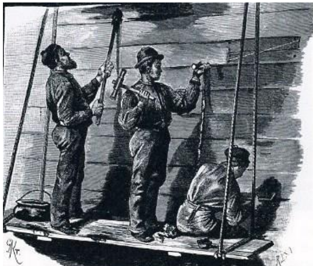
Kalfateren; Quelle: Zur See , von Henk Verlagsanstalt und Druckerei, Hamburg, 1885
